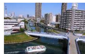
小名木川クローバー橋
